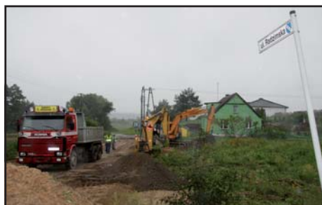
Naprawa zniszczonej ul. Radzimskiej.
